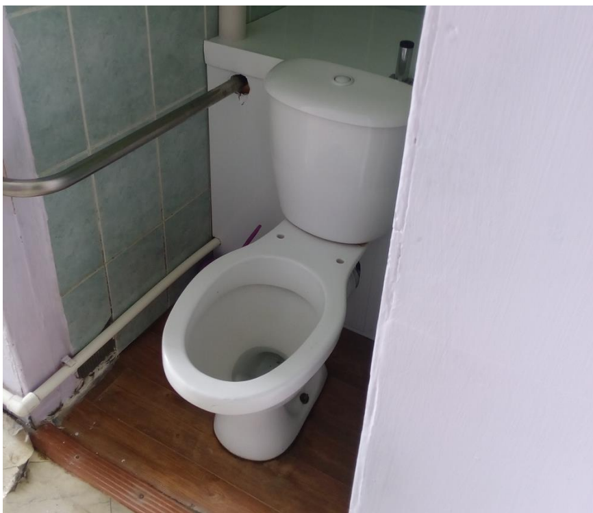
Рис. 12 – Ашапский ПНИ. Узкий туалет без двери, нет рядом места для коляски.
